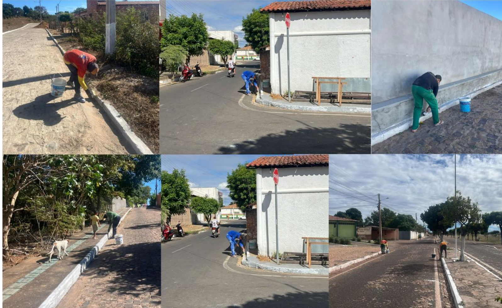
Figura 89: Mural de registros de pinturas de meio-fio nas vias de Ipiranga do Piauí
