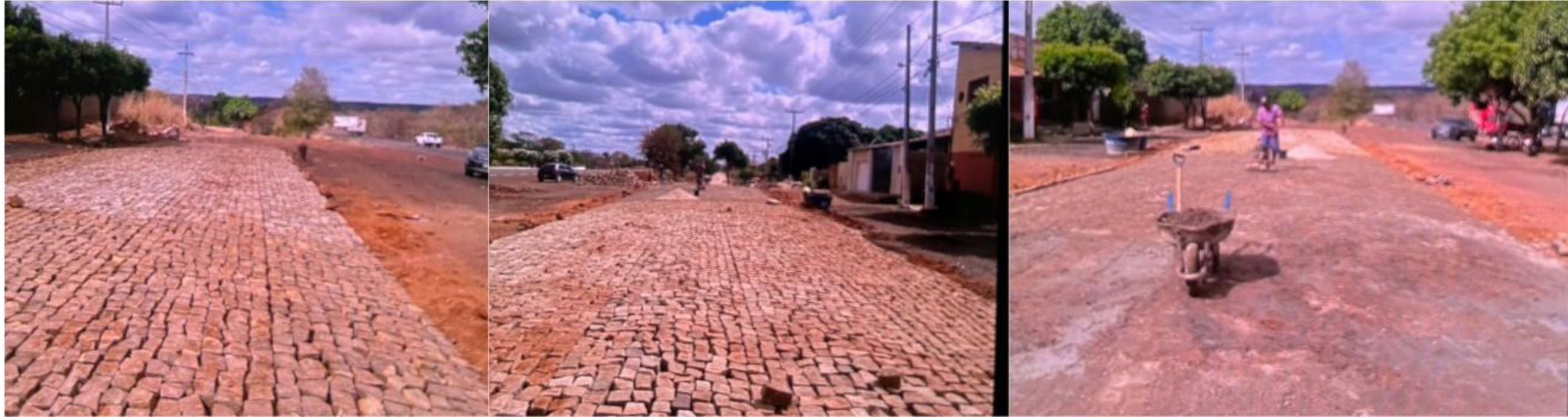
Figura 94: Construção de novos calçamentos
