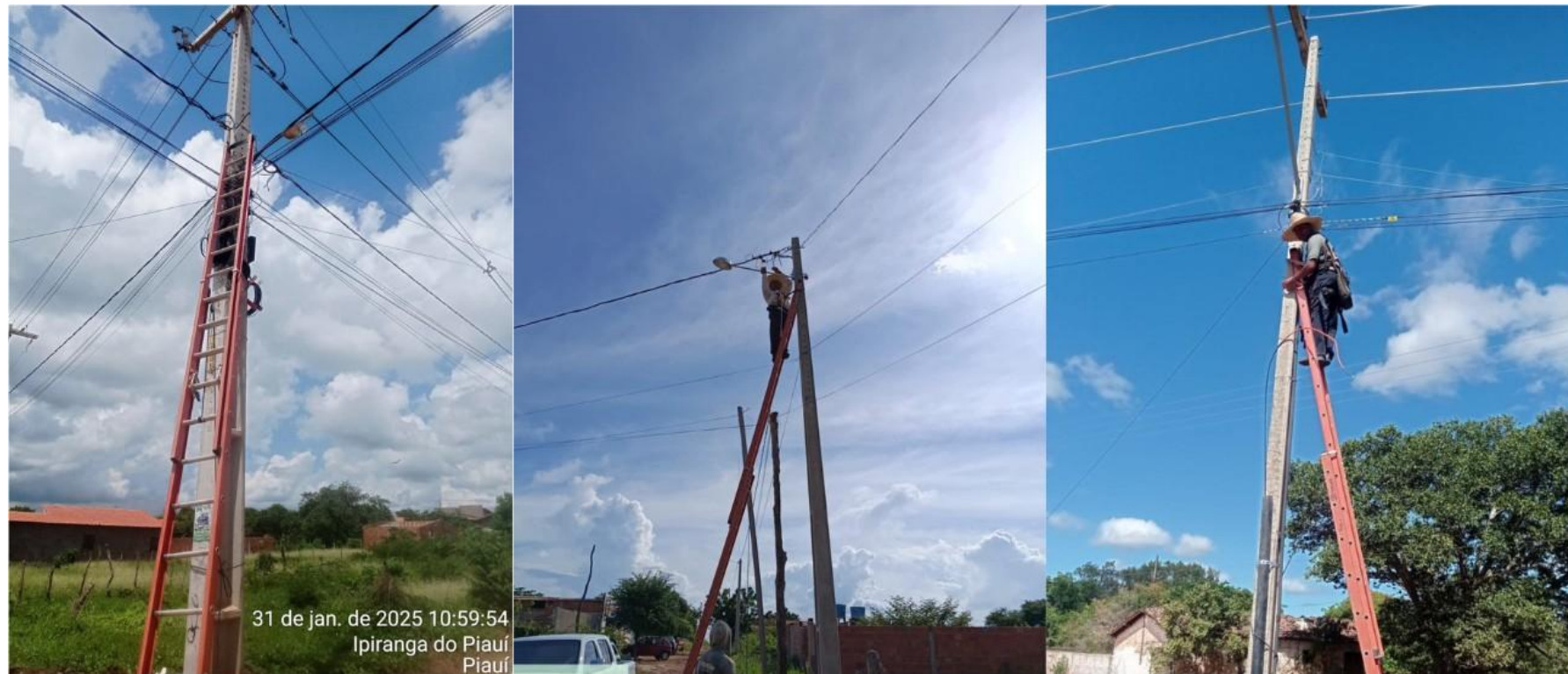
Figura 91: Mural de registros da execução de serviços na iluminação pública
