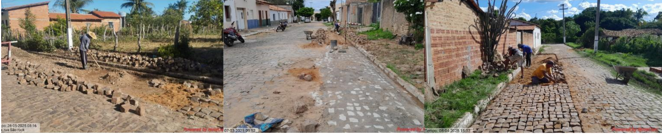
Figura 93: Reformas de calçamentos existentes
