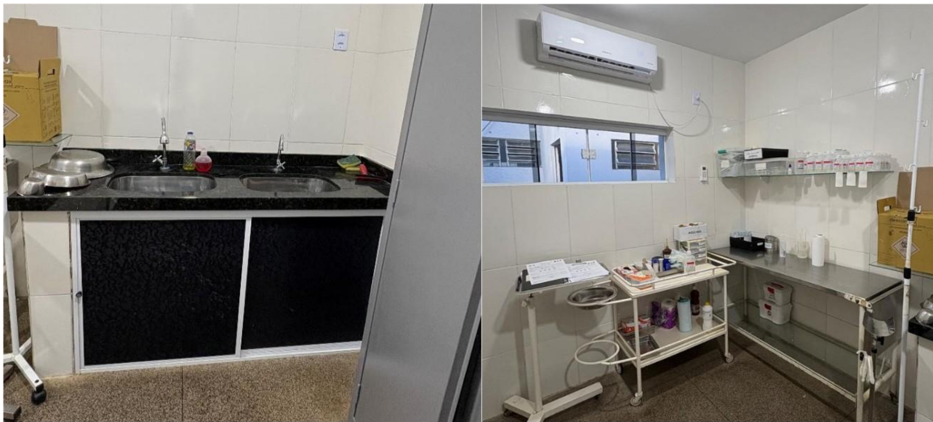
Figura 16 - Imagem após modernização em Sala de Procedimentos
