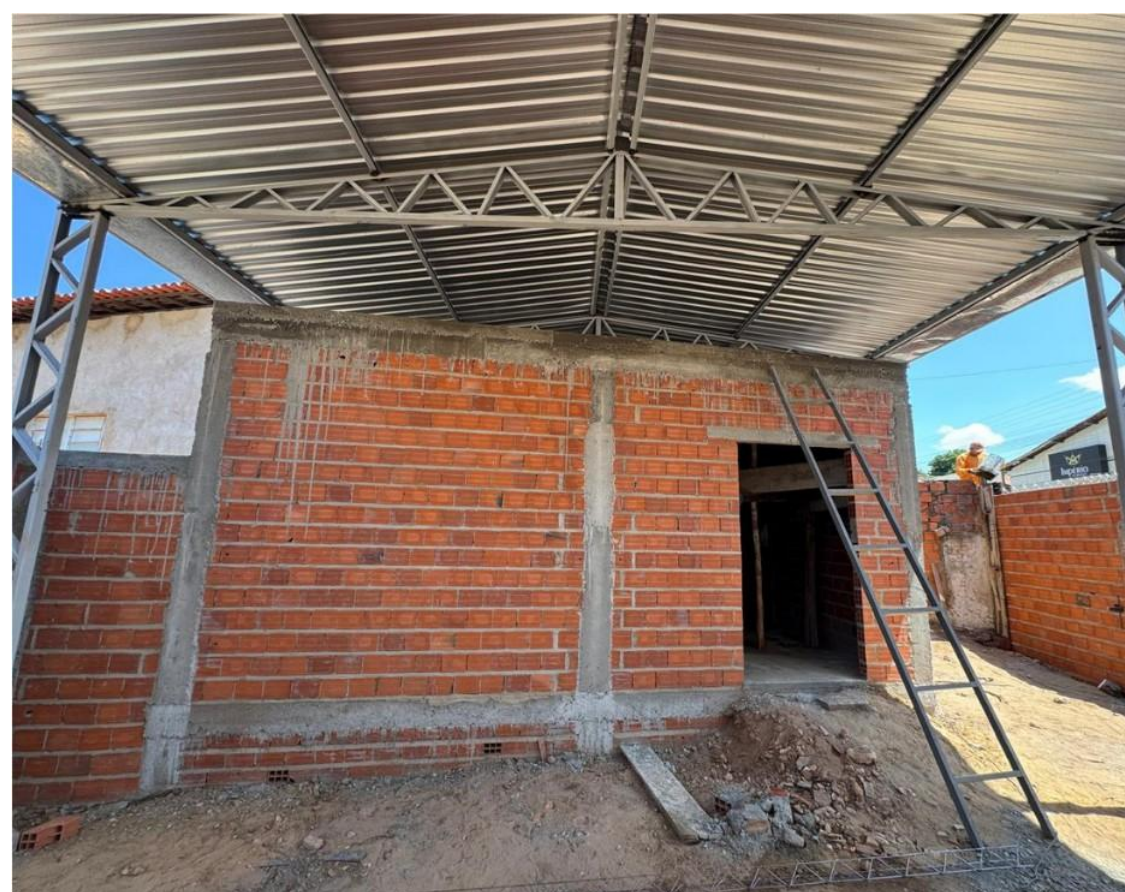
Figura 105: Construção de depósito e garagem da Secretaria Municipal de Educação.
